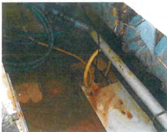
Figuur 25 Kruipruimte met ijzersporen, put met pomp onder de plank
