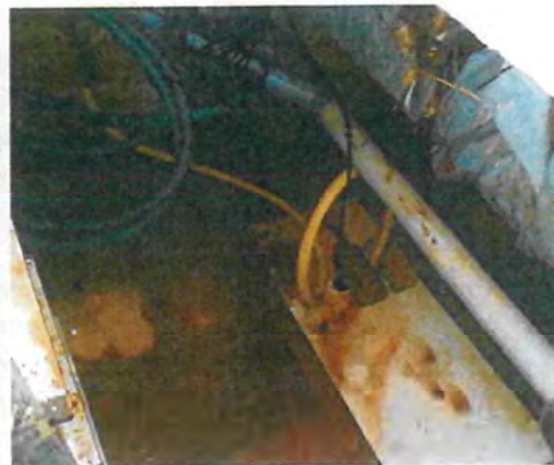
Kruipruimte met ijzersporen, put met pomp onder de plank op de foto
