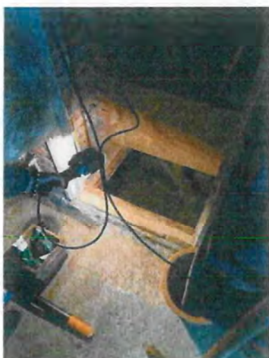
Figuur 1 Kruipruimte in de garage
