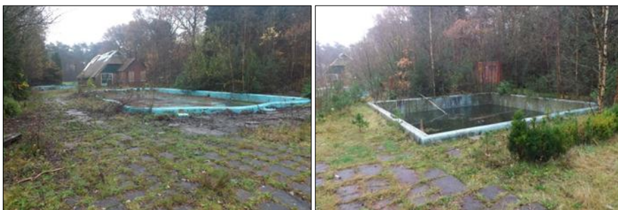
Ondiep zwembad (links) en dieper zwembad (rechts)
