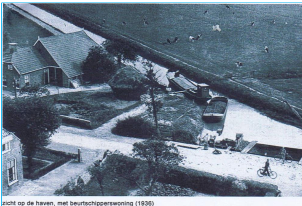
zicht op de haven, met beurtschipperswoning (1936)
