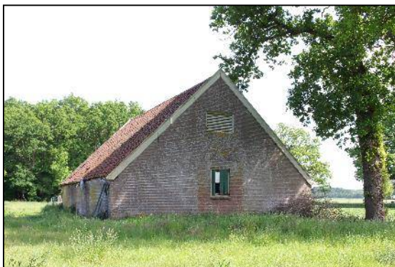
Afbeelding 2.2. De te slopen vervallen schuur westzijde.
