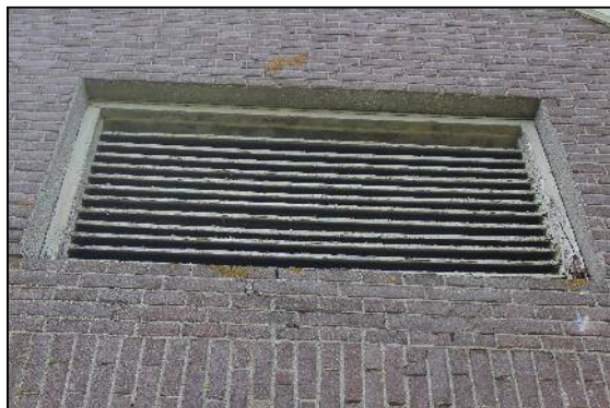
Afbeelding 2.4. Ventilatie-rooster in oude schuur.
