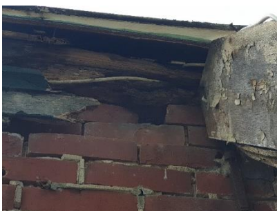
Figuur 7 Potentiële invliegopeningen voor vleermuizen bij afgebrokkeld metselwerk en verrot houtwerk langs de dakrand (links en midden: Gebouw 1, rechts: Gebouw 2).
