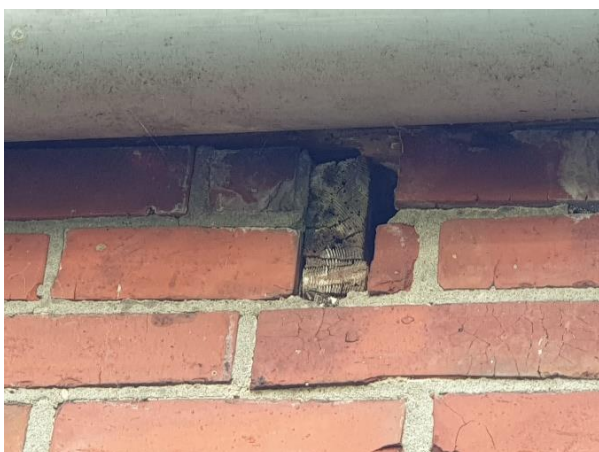
Figuur 6 Links: Potentiële invliegopeningen voor vleermuizen bij afgebrokkeld metselwerk. Recht: beschadigd ventilatierooster in Gebouw 1.
