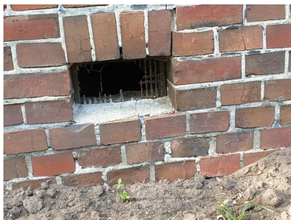
Figuur 6 Links: Potentiële invliegopeningen voor vleermuizen bij afgebrokkeld metselwerk. Recht: beschadigd ventilatierooster in Gebouw 1.
