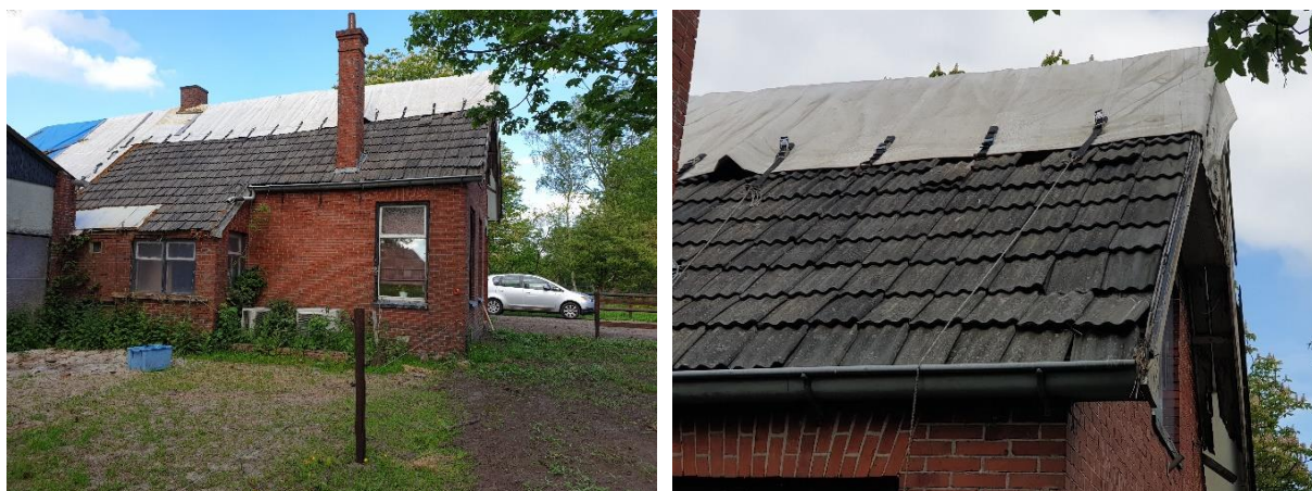
Figuur 3 Links: Indruk van Gebouw 1 (westzijde). Rechts, close-up van het dak van Gebouw 1.
