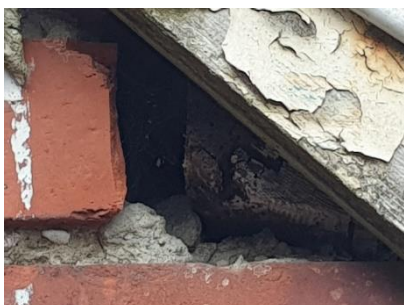
Figuur 7 Potentiële invliegopeningen voor vleermuizen bij afgebrokkeld metselwerk en verrot houtwerk langs de dakrand (links en midden: Gebouw 1, rechts: Gebouw 2).
