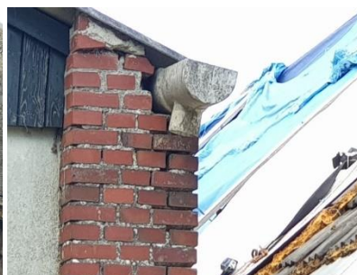
Figuur 7 Potentiële invliegopeningen voor vleermuizen bij afgebrokkeld metselwerk en verrot houtwerk langs de dakrand (links en midden: Gebouw 1, rechts: Gebouw 2).
