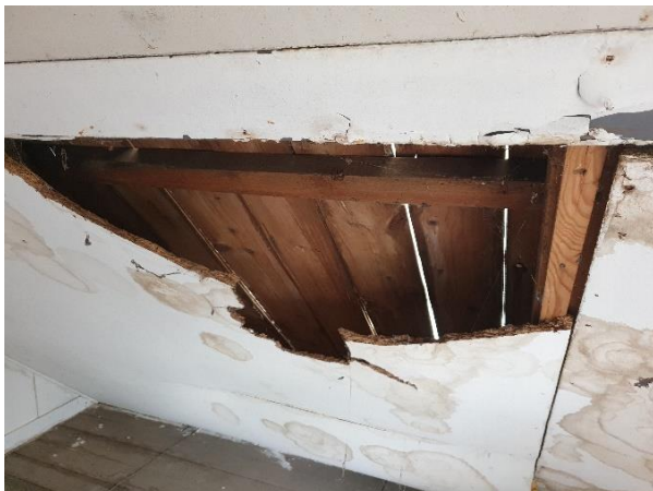
Figuur 8 Toegankelijke ruimte onder het dak van Gebouw 1.
