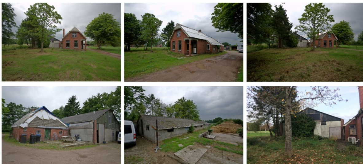
Figuur 8: huidige bebouwing is in slechte of vervallen staat.
