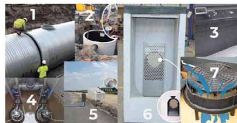
1: Ondergrondse buffertank voor duizenden m 3 opslag. 2: Ondergrondse waterzuivering van het bufferwater. 3 en 4: Distributie regenwater vanuit bufferopslag via regelkleppen en pompsystemen naar gebruikers. 5: Aangepaste straatkolkken voor regenwaterafvoer (onder) snelweg, zeer eenvoudig en energielooos. 6: Kolk voor regenwater, grote vrije doorlaat met vuilvanger. 7: Rioolontlastklep, putdeksel kan niet weg bij opstuikend water en ontlast de rioldruk.
