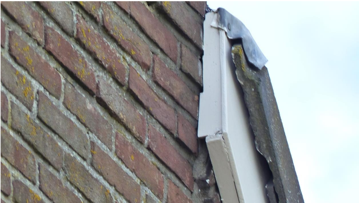
Figuur 4.3 Er is ruimte onder de kantpannen voor vleermuizen.
