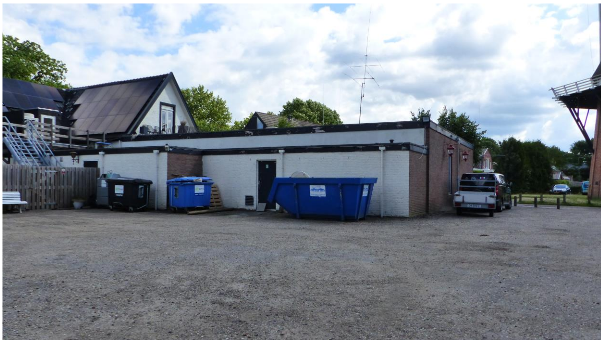
Figuur 1.5 De achterzijde van het zaaldeel van “Bij Boon” met een verharde parkeerplaats.
