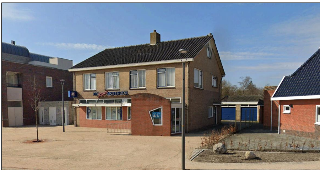
Fig. 1.1: Een weergave van het bestaande pand aan de Heerestraat 228 te Roden.
