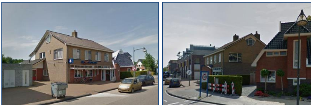
Figuur 2.4: Aanzicht van het huidige pand in het plangebied.
