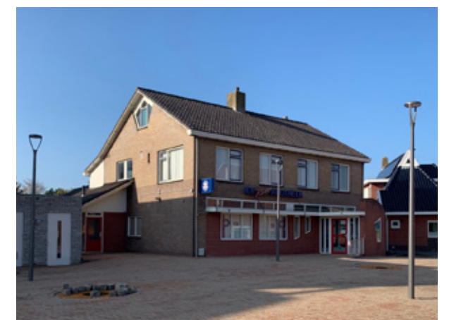
Beeld van de reeds uitgevoerde werkzaamheden.
