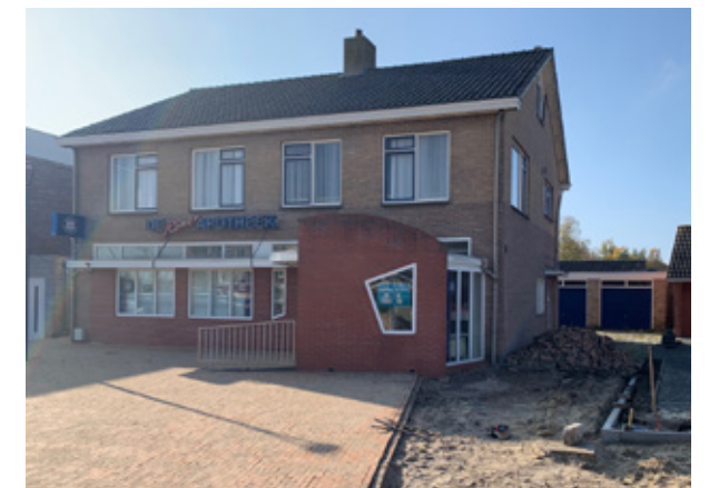
Beeld van de reeds uitgevoerde werkzaamheden.
