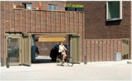
Ingang parkeren op eigen terrein en erfafsluiting als onderdeel van de architectuur
