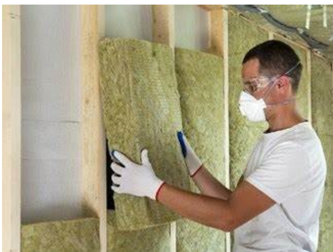
Figuur 2 Isoleren van een woning (bron: Milieu Centraal)
