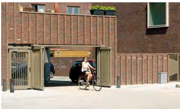
ingang parkeren op eigen terrein en erfafscheiding als onderdeel van de architectuur
