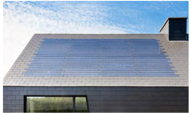
integratie zonnepanelen in de architectuur
