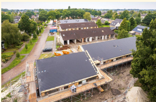
Voorbeeld van een renovatiebuurt in Roden (Woonborg, Van Wijnen)
